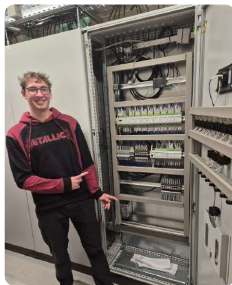
V této skříni se převádí digitální signál na analogový pro řízení měničů čerpadel; prezentuje Lukáš Matějka.
